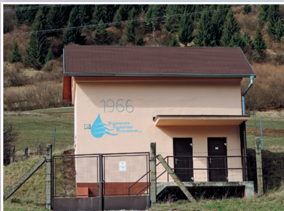
Vodárenský objekt vodojem Biely Potok 150 m 3
