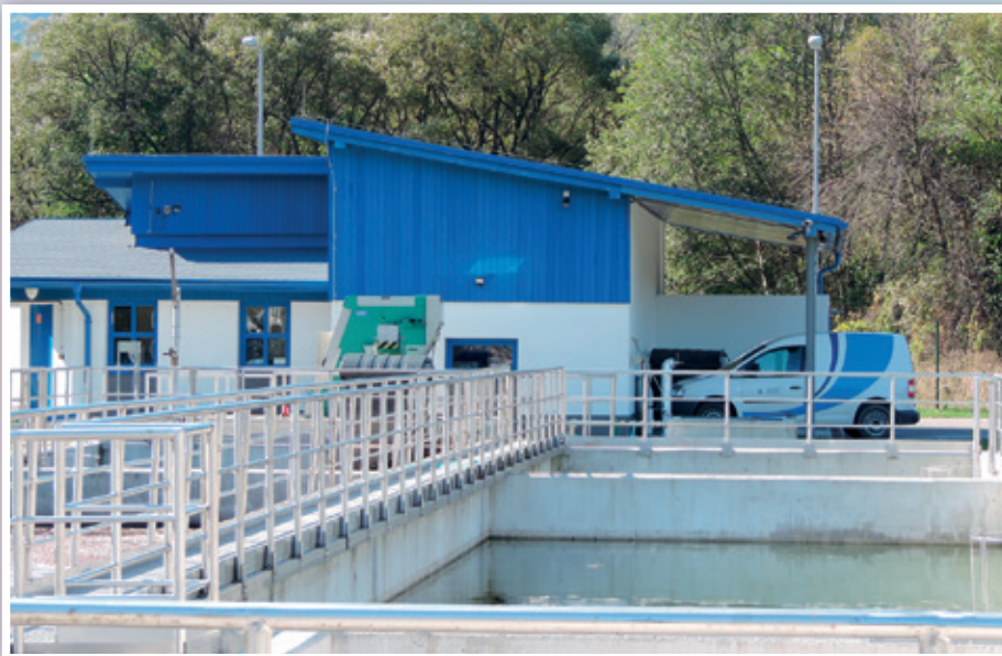
ČOV Liptovská Osada
