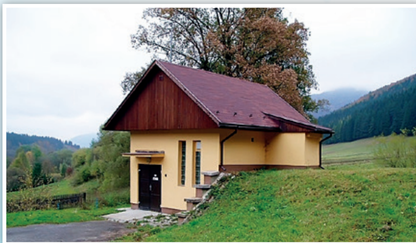
Vodárenský objekt – prerušovací VDJ L. Osada 150 m 3
