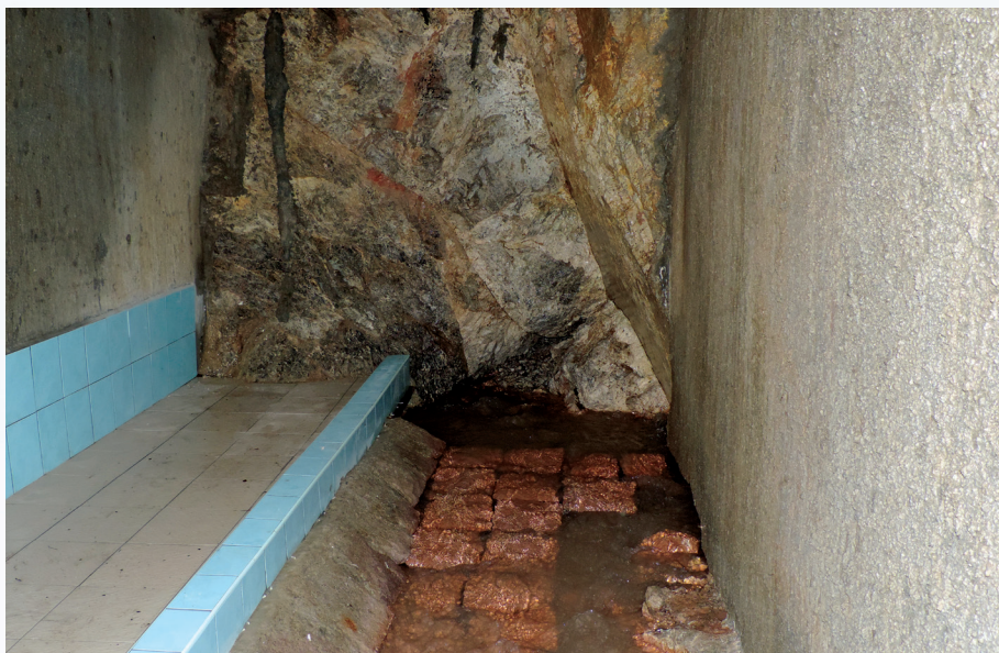
Vodný zdroj Pod Javorom
